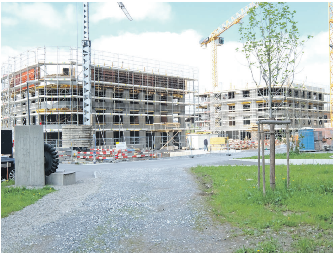
Die Baustelle der Wohnbausiedlung Birkenweg in Vaduz am 16. April 2016. (Foto: ZVG)
